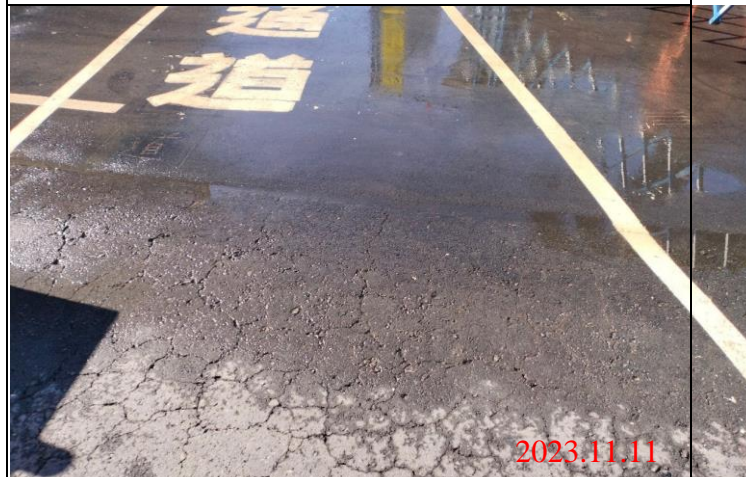
巡查日期地點：112.11.11/ Y23車站 照片說明：路面龜裂狀況
