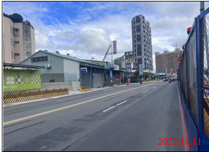
巡查日期地點：112.11.11/ Y22車站 照片說明：路面狀況
