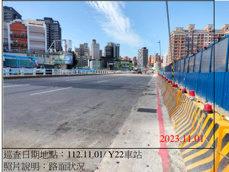
巡查日期地點：112.11.01/ Y22車站 照片說明：路面狀況
