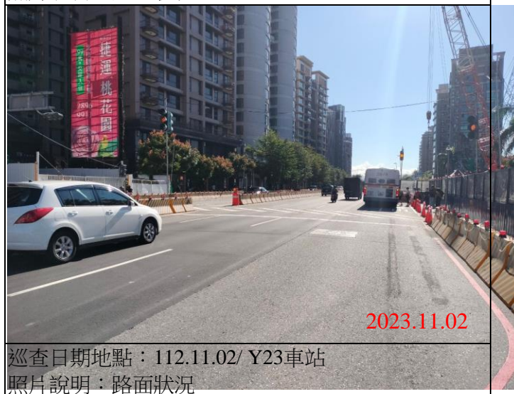
巡查日期地點：112.11.02/ Y23車站 照片說明：路面狀況
