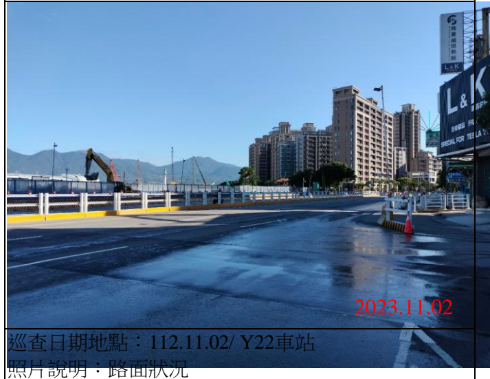
巡查日期地點：112.11.02/ Y22車站 照片說明：路面狀況
