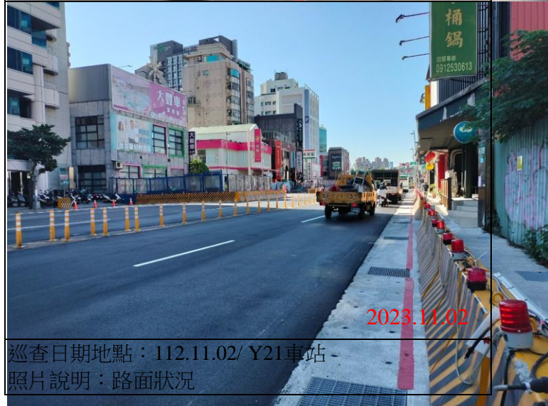
巡查日期地點：112.11.02/ Y21車站 照片說明：路面狀況
