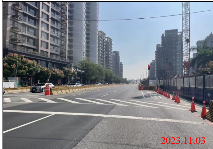
巡查日期地點：112.11.03/ Y23車站 照片說明：路面狀況
