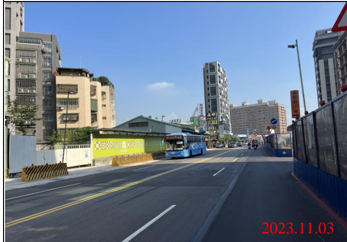
巡查日期地點：112.11.03 Y22車站 照片說明：路面狀況
