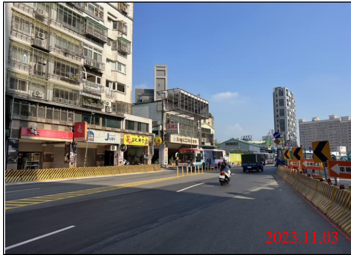
巡查日期地點：112.11.03 Y22車站 照片說明：路面狀況
