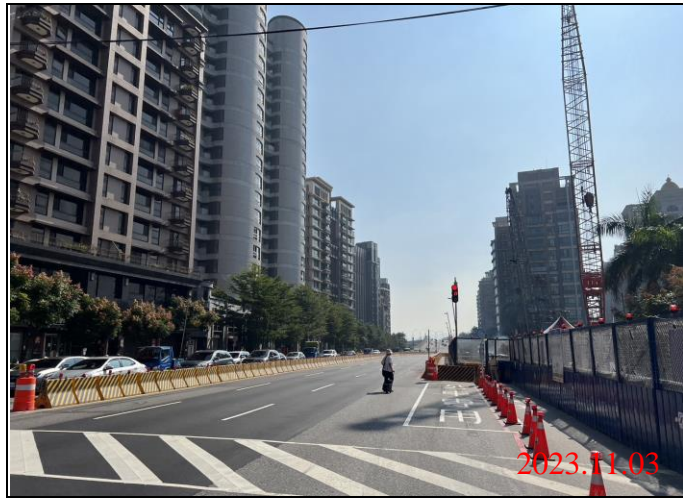
巡查日期地點：112.11.03/ Y23車站 照片說明：路面狀況
