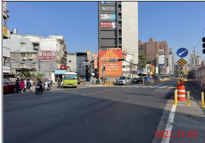
巡查日期地點：112.11.03 Y21車站 照片說明：路面狀況
