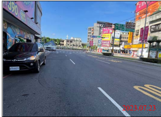
巡查日期地點：112.07.23/ Y21車站 照片說明：路面狀況
