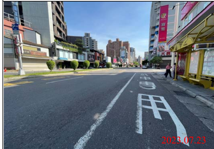
巡查日期地點：112.07.23/ Y21車站 照片說明：路面狀況
