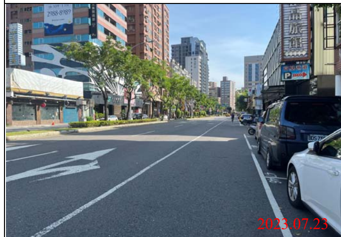
巡查日期地點：112.07.21/ Y23車站 照片說明：路面狀況
