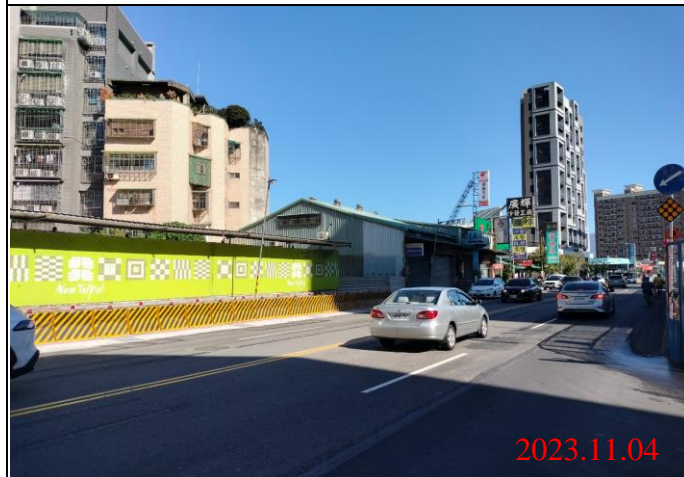
巡查日期地點：112.11.04/22車站 照片說明：路面狀況
