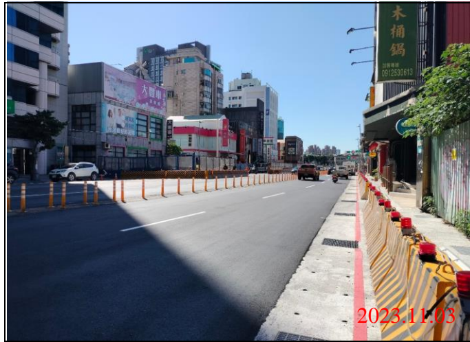
巡查日期地點：112.11.04 Y21車站 照片說明：路面狀況
