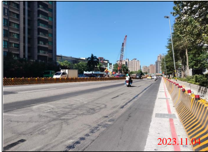
巡查日期地點：112.11.04/ Y23車站 照片說明：路面狀況
