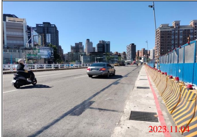
巡查日期地點：112.11.04/Y22車站 照片說明：路面狀況
