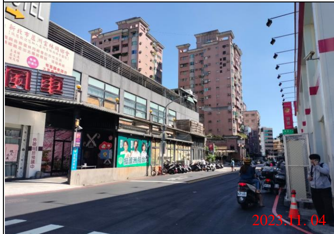
巡查日期地點：112.11.04 Y21車站 照片說明：路面狀況
