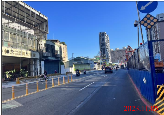
巡查日期地點：112.11.05/Y22車站 照片說明：路面狀況
