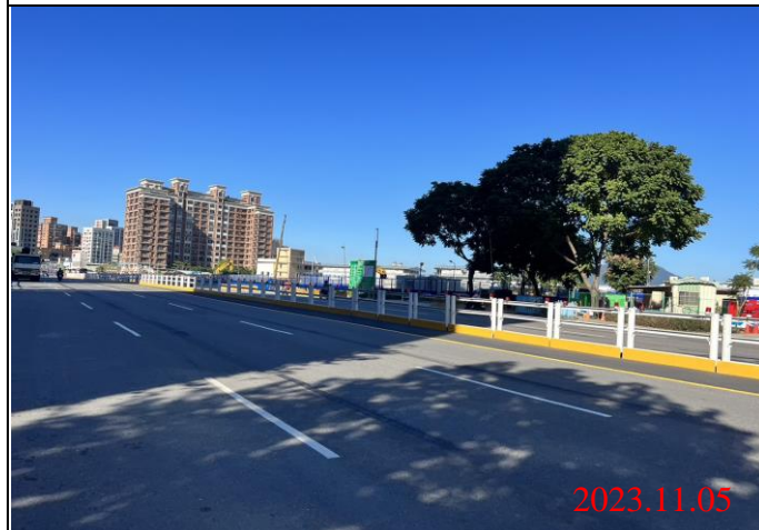
巡查日期地點：112.11.05/22車站 照片說明：路面狀況
