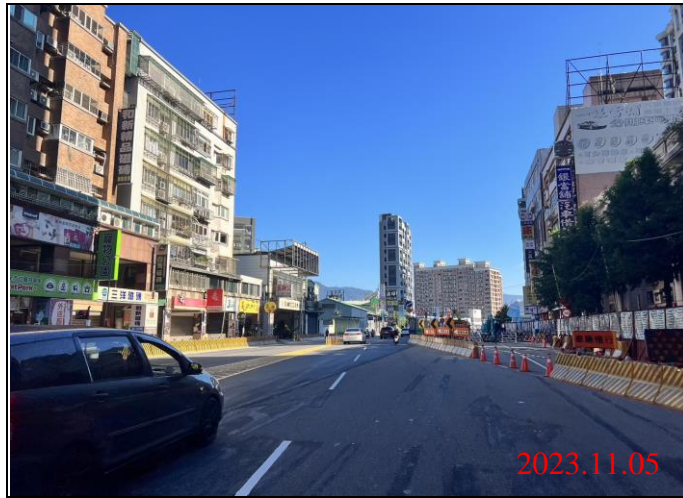
巡查日期地點：112.11.05 Y22車站 照片說明：路面狀況
