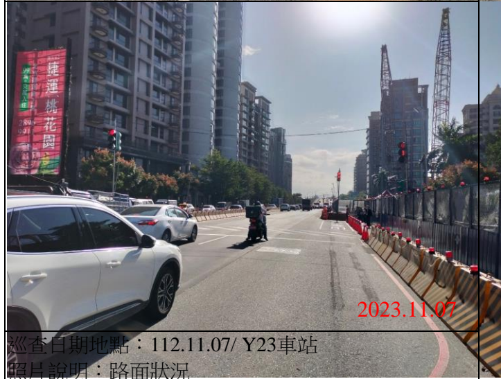
巡查日期地點：112.11.07/ Y23車站 照片說明：路面狀況
