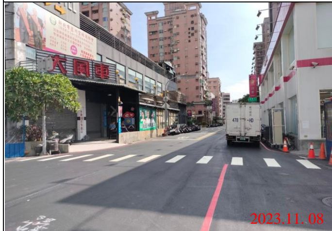
巡查日期地點：112.11.08/ Y21車站 照片說明：路面狀況
