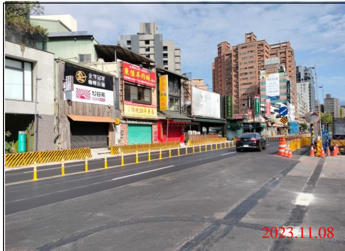
巡查日期地點：112.11.08/ Y21車站 照片說明：路面狀況
