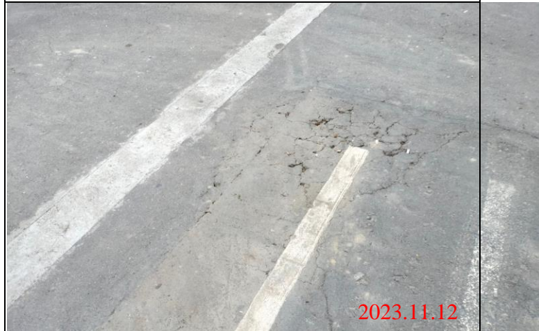
巡查日期地點：112.11.12/ Y23車站 照片說明：路面龜裂狀況
