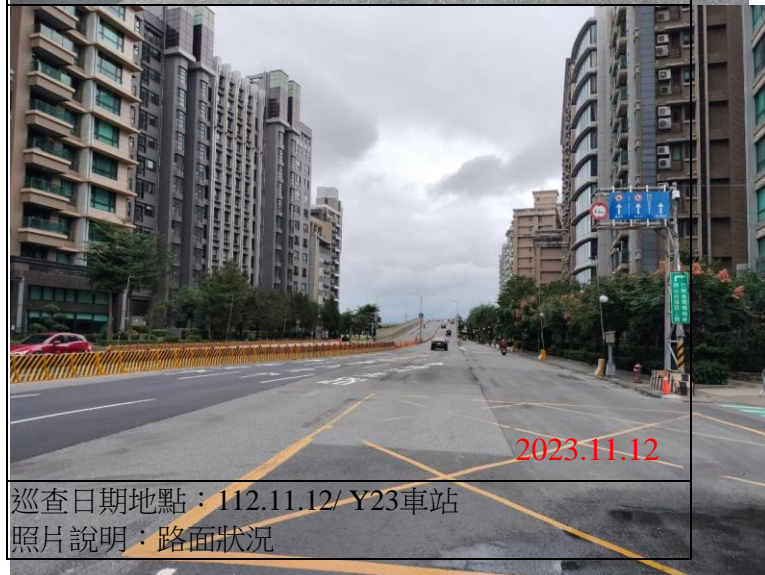
巡查日期地點：112.11.12/ Y23車站 照片說明：路面狀況
