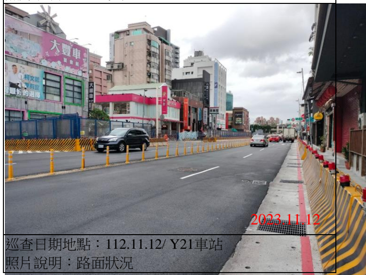
巡查日期地點：112.11.12/ Y21車站 照片說明：路面狀況
