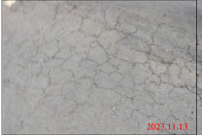
巡查日期地點：112.11.13/ Y23車站 照片說明：路面龜裂狀況
