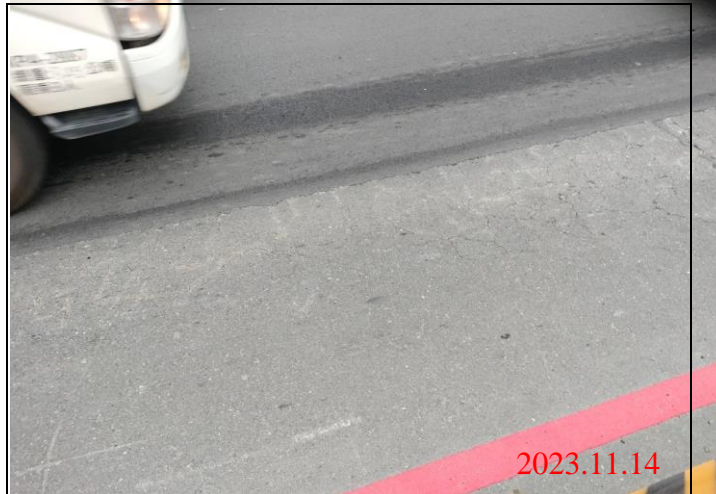
巡查日期地點：112.11.14/ Y23車站 照片說明：路面龜裂狀況
