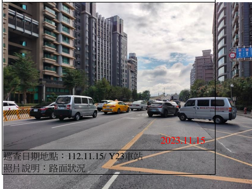
巡查日期地點：112.11.15/ Y23車站 照片說明：路面狀況
