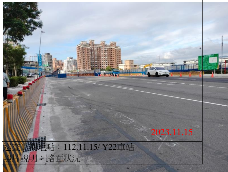
巡查日期地點：112.11.15/ Y22車站 照片說明：路面狀況
