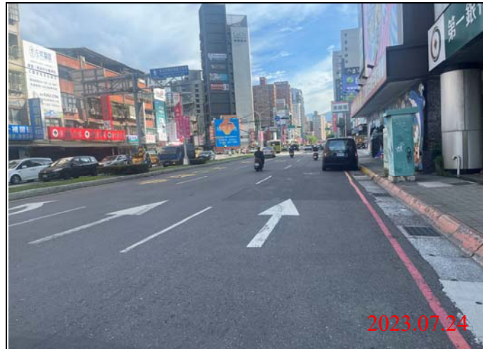
巡查日期地點：112.07.24/ Y21車站 照片說明：路面狀況
