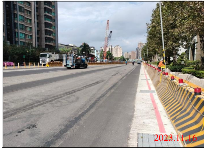
巡查日期地點：112.11.16/ Y23車站 照片說明：路面狀況
