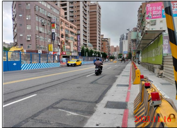
巡查日期地點：112.11.16/ Y22車站 照片說明：路面狀況
