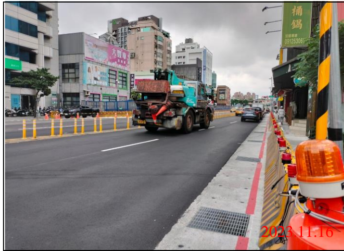
巡查日期地點：112.11.16/ Y21車站 照片說明：路面狀況
