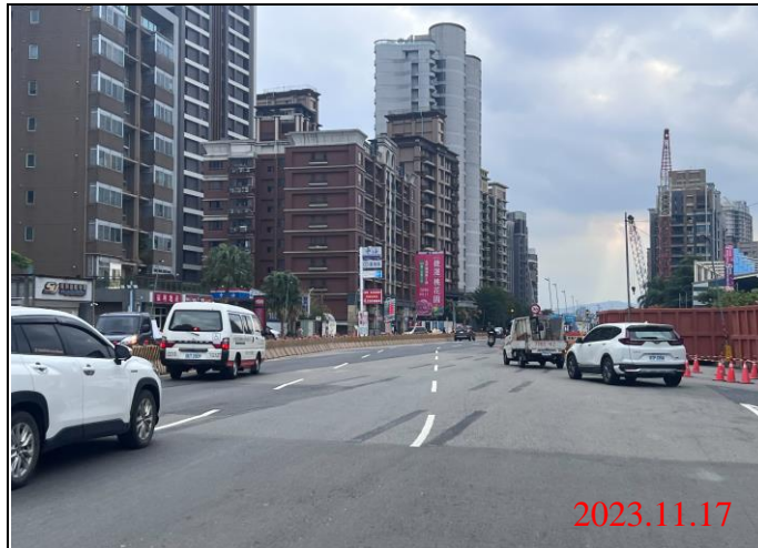
巡查日期地點：112.11.17/ Y23車站 照片說明：路面狀況
