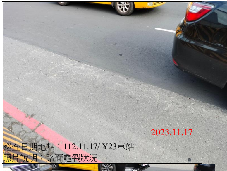
巡查日期地點：112.11.17/ Y23車站 照片說明：路面龜裂狀況
