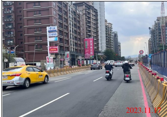
巡查日期地點：112.11.17/ Y23車站 照片說明：路面狀況
