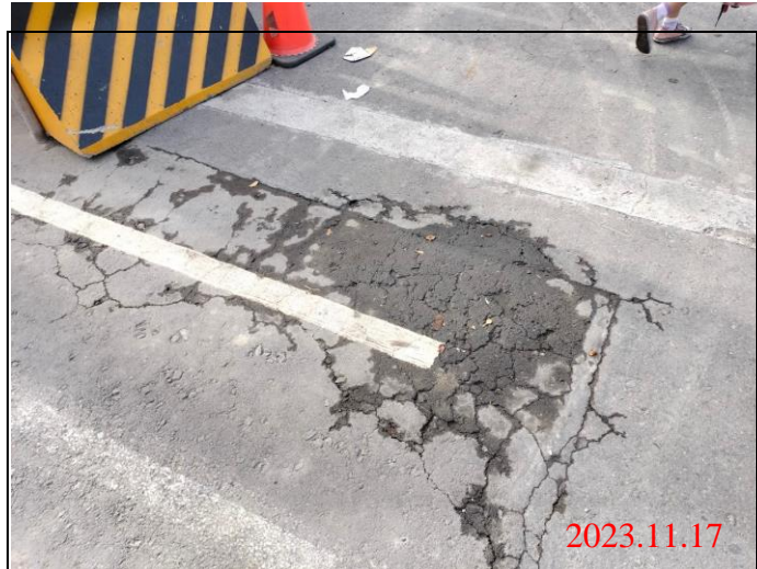
巡查日期地點：112.11.17/ Y23車站 照片說明：路面龜裂狀況
