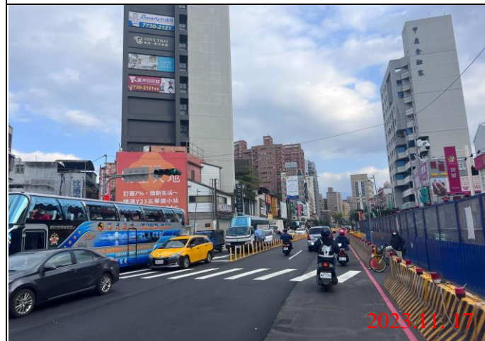
巡查日期地點：112.11.17/ Y21車站 照片說明：路面狀況
