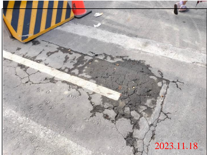
巡查日期地點：112.11.18/ Y23車站 照片說明：路面龜裂狀況
