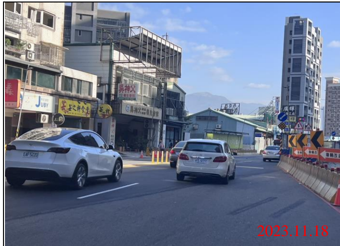
巡查日期地點：112.11.18/ Y22車站 照片說明：路面狀況
