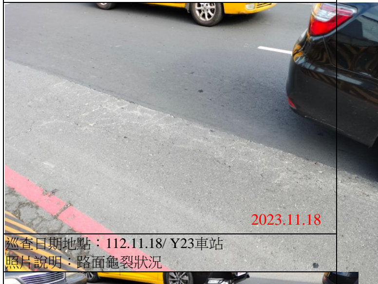
巡查日期地點：112.11.18/ Y23車站 照片說明：路面龜裂狀況
