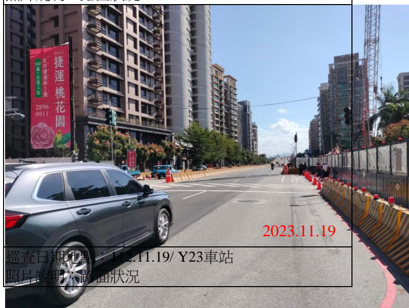
巡查日期地點：112.11.19/ Y23車站 照片說明：路面狀況
