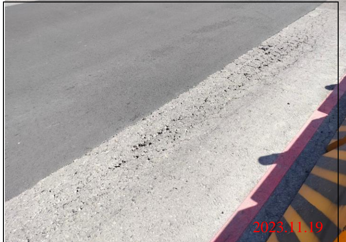
巡查日期地點：112.11.19/ Y23車站 照片說明：路面龜裂狀況
