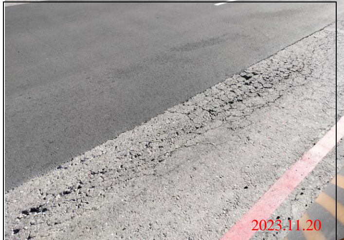
巡查日期地點：112.11.20/ Y23車站 照片說明：路面龜裂狀況
