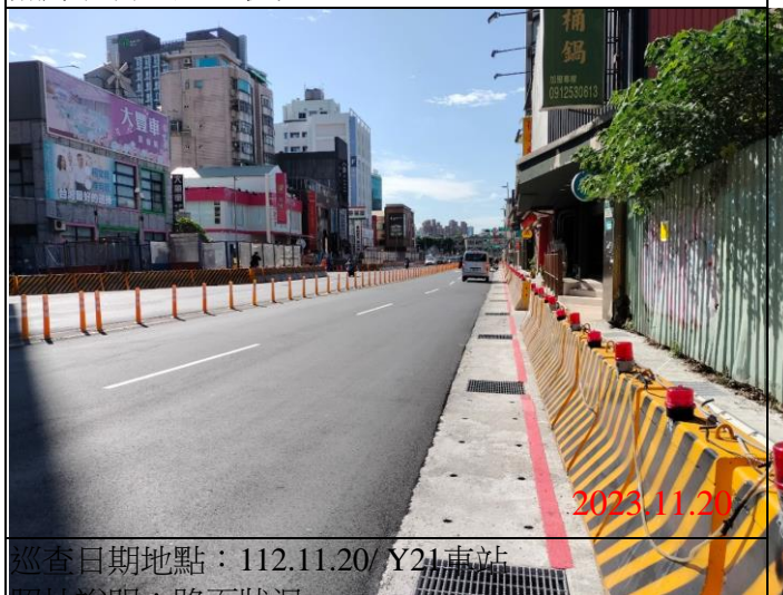
巡查日期地點：112.11.20/ Y21車站 照片說明：路面狀況
