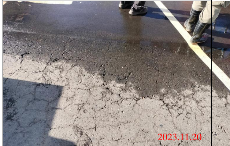
巡查日期地點：112.11.20/ Y23車站 照片說明：路面龜裂狀況
