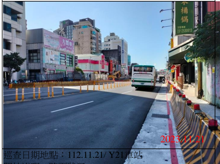
巡查日期地點：112.11.21/ Y21車站 照片說明：路面狀況
