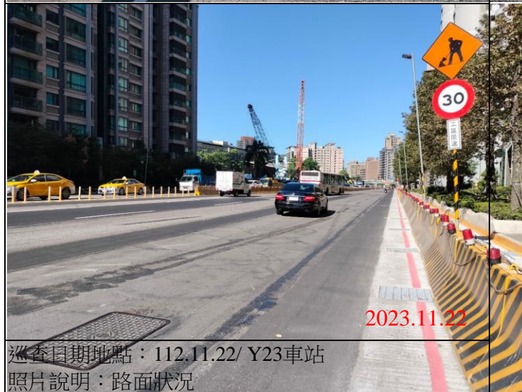
巡查日期地點：112.11.22/ Y23車站 照片說明：路面狀況
