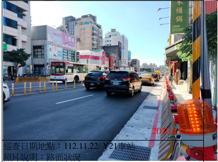
巡查日期地點：112.11.22/ Y21車站 照片說明：路面狀況
