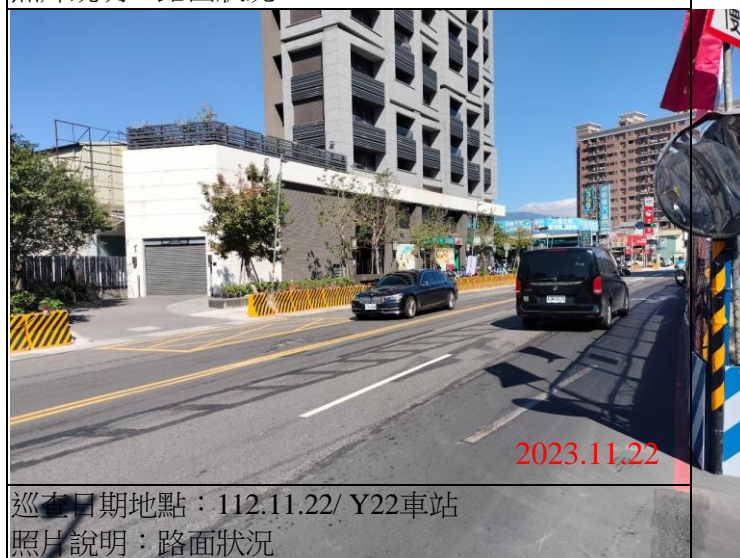
巡查日期地點：112.11.22/ Y22車站 照片說明：路面狀況
