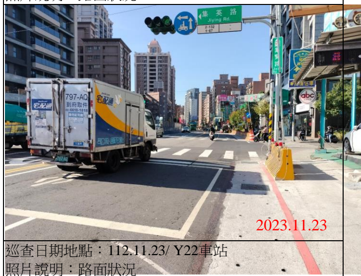
巡查日期地點：112.11.23/ Y22車站 照片說明：路面狀況
