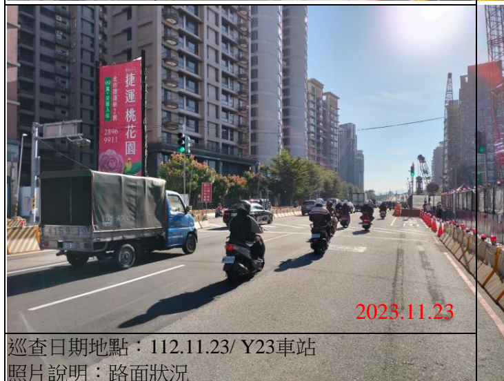
巡查日期地點：112.11.23/ Y23車站 照片說明：路面狀況
