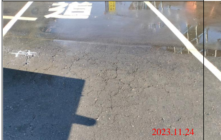
巡查日期地點：112.11.24/ Y23車站 照片說明：路面龜裂狀況
