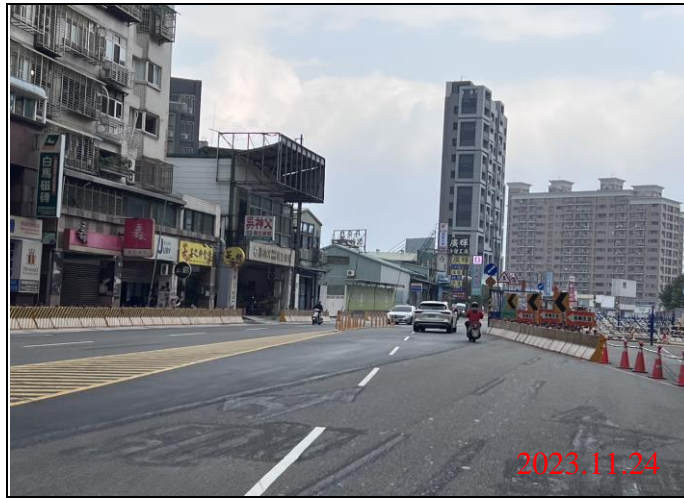
巡查日期地點：112.11.24/ Y22車站 照片說明：路面狀況
