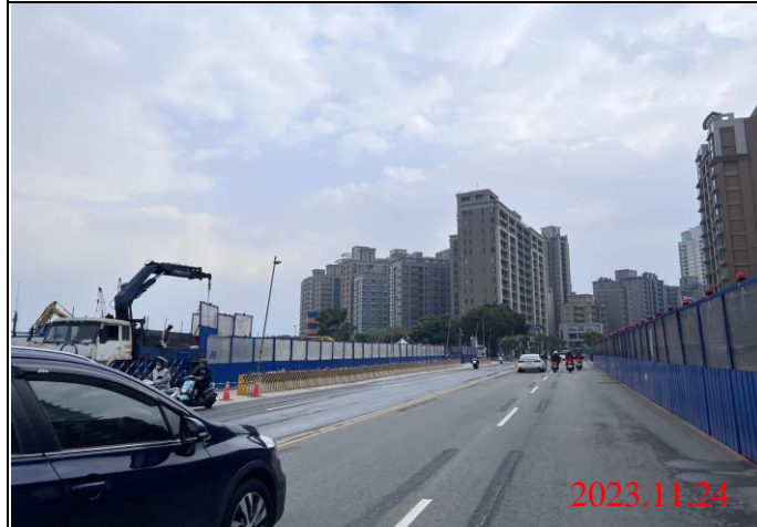
巡查日期地點：112.11.24/ Y22車站 照片說明：路面狀況
