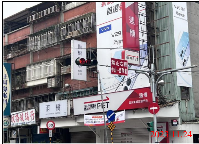
巡查日期地點：112.11.24/ Y21車站 照片說明：牌面設置狀況
