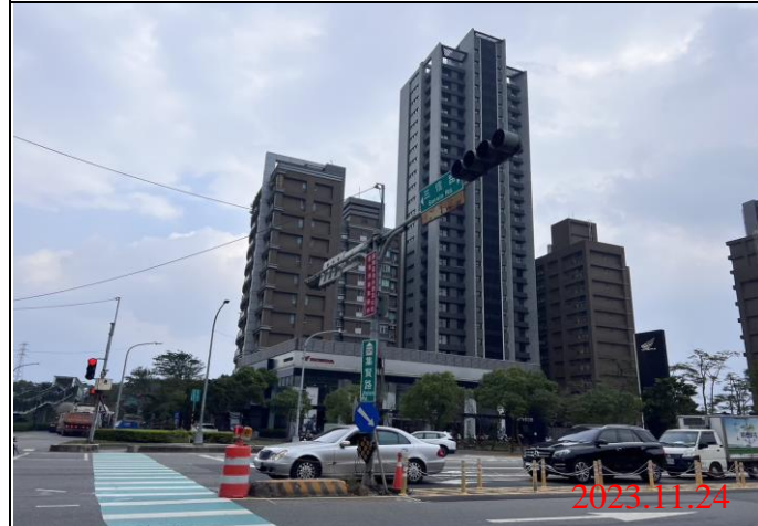
巡查日期地點：112.11.24/ Y23車站 照片說明：牌面設置狀況
