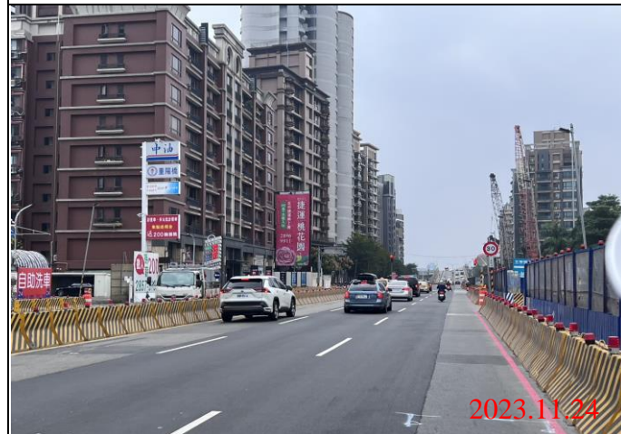
巡查日期地點：112.11.24/ Y23車站 照片說明：路面狀況
