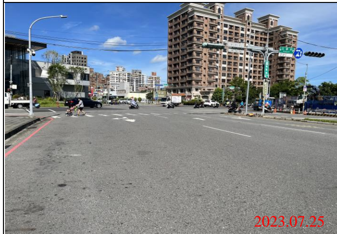
巡查日期地點：112.07.25/ Y22車站 照片說明：路面狀況
