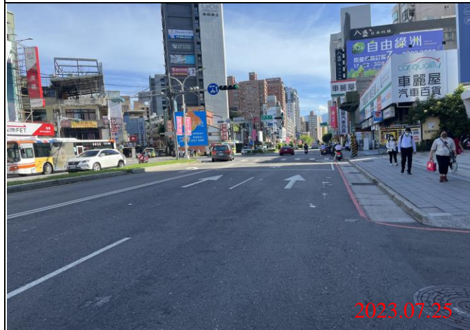
巡查日期地點：112.07.25/ Y21車站 照片說明：路面狀況
