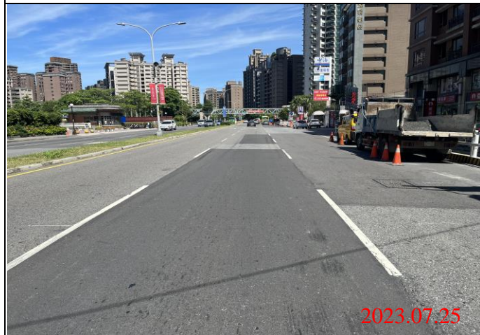
巡查日期地點：112.07.25/ Y23車站 照片說明：路面狀況
