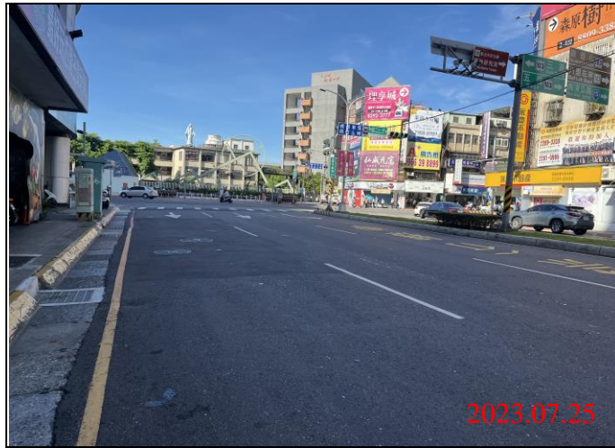
巡查日期地點：112.07.25/ Y21車站 照片說明：路面狀況
