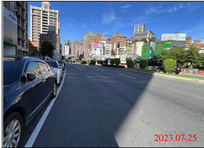
巡查日期地點：112.07.25/ Y22車站 照片說明：路面狀況
