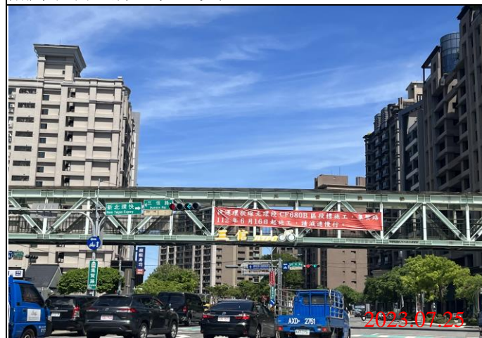
巡查日期地點：112.07.25/ Y23車站 照片說明：牌面設置狀況
