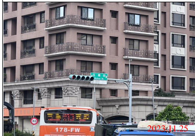
巡查日期地點：112.11.25/ Y22車站 照片說明：牌面設置狀況
