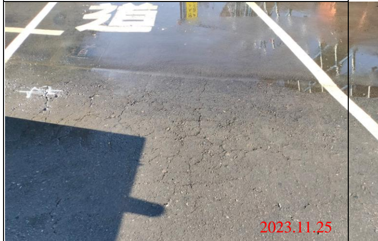
巡查日期地點：112.11.25/ Y23車站 照片說明：路面龜裂狀況
