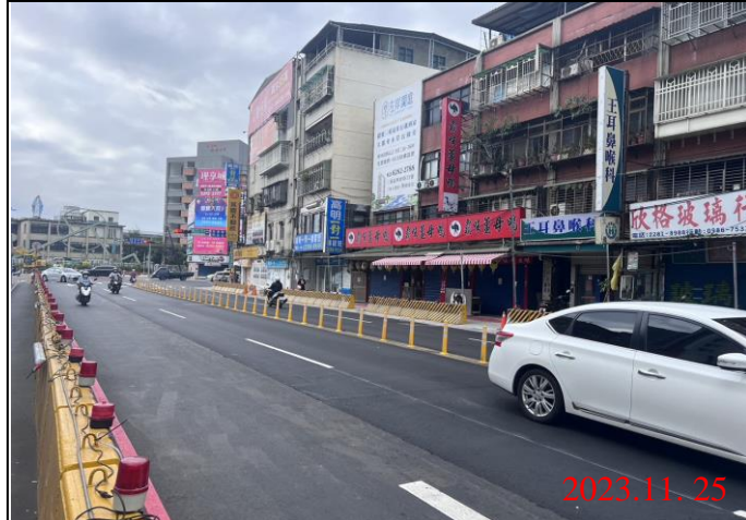
巡查日期地點：112.11.25/ Y21車站 照片說明：路面狀況
