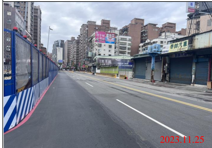
巡查日期地點：112.11.25/ Y22車站 照片說明：路面狀況
