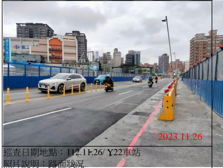
巡查日期地點：112.11.26/ Y22車站 照片說明：路面狀況
