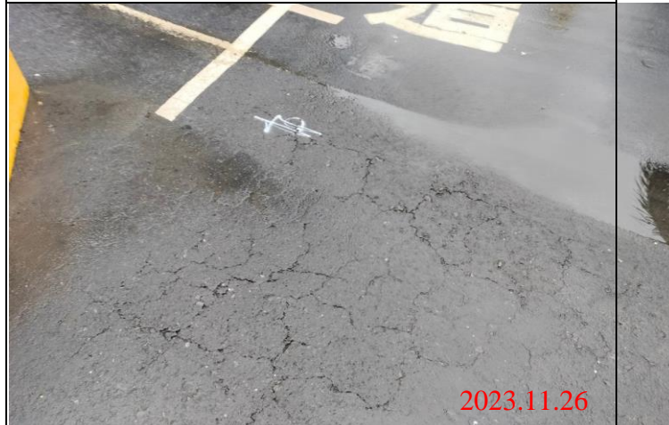
巡查日期地點：112.11.26/ Y23車站 照片說明：路面龜裂狀況
