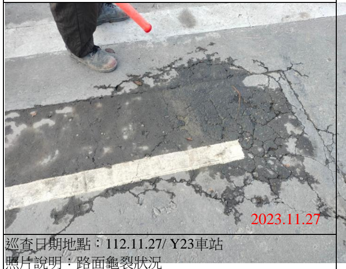
巡查日期地點：112.11.27/ Y23車站 照片說明：路面龜裂狀況
