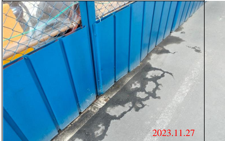
巡查日期地點：112.11.27/ Y23車站 照片說明：路面龜裂狀況
