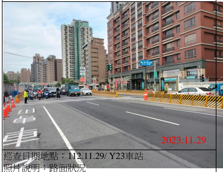
巡查日期地點：112.11.29/ Y23車站 照片說明：路面狀況
