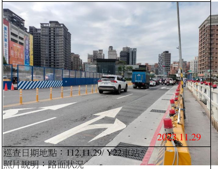
巡查日期地點：112.11.29/ Y22車站 照片說明：路面狀況
