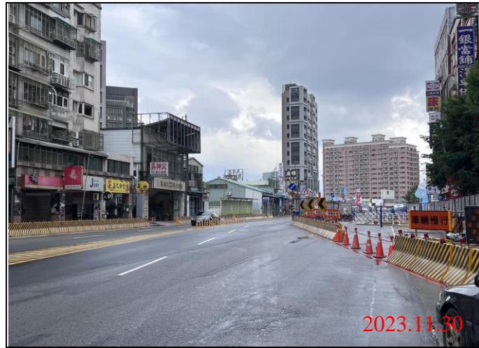
巡查日期地點：112.11.30/ Y22車站 照片說明：路面狀況
