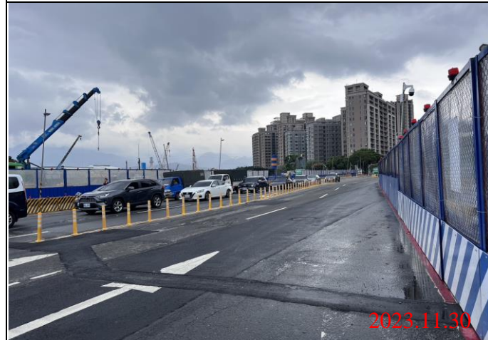
巡查日期地點：112.11.30/ Y22車站 照片說明：路面狀況
