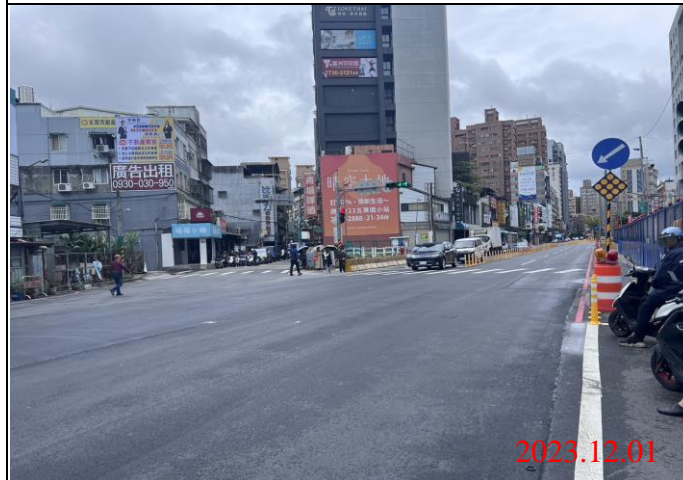
巡查日期地點：112.12.01/ Y21車站 照片說明：路面狀況
