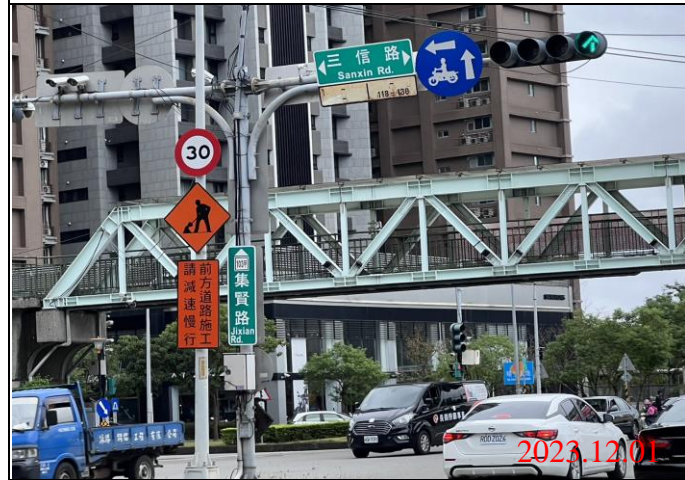
巡查日期地點：112.12.01/ Y23車站 照片說明：牌面設置狀況
