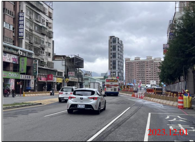
巡查日期地點：112.12.01/ Y22車站 照片說明：路面狀況
