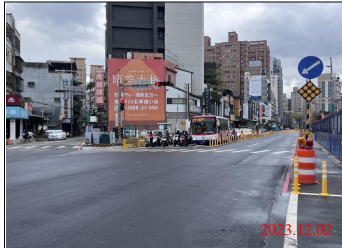
巡查日期地點：112.12.02/ Y21車站 照片說明：路面狀況
