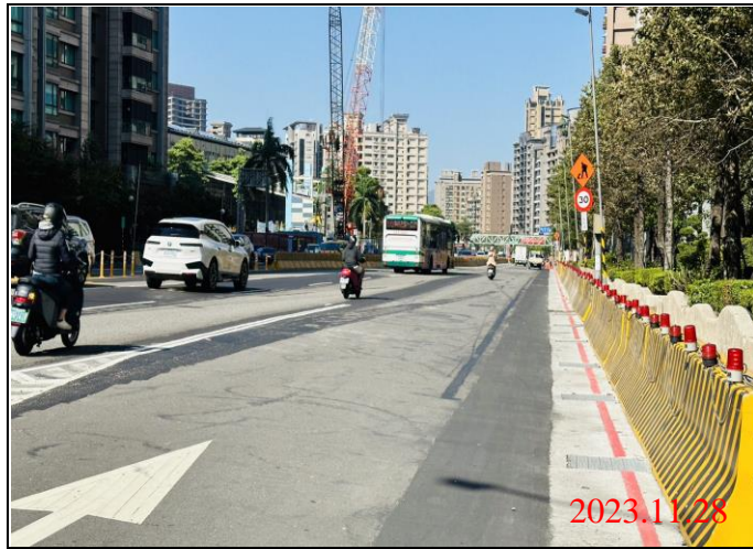
巡查日期地點：112.11.28/ Y23車站 照片說明：路面狀況
