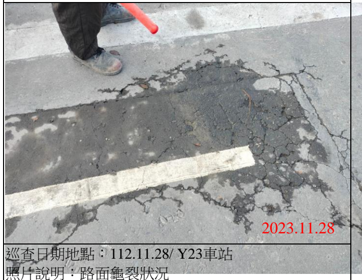
巡查日期地點：112.11.28/ Y23車站 照片說明：路面龜裂狀況
