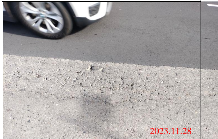
巡查日期地點：112.11.28/ Y23車站 照片說明：路面龜裂狀況
