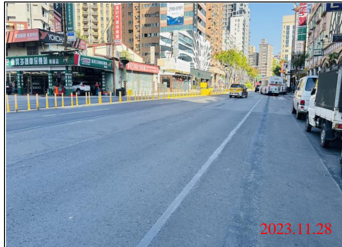
巡查日期地點：112.11.28/ Y21車站 照片說明：路面狀況
