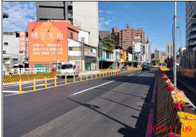
巡查日期地點：112.11.09/ Y21車站 照片說明：路面狀況
