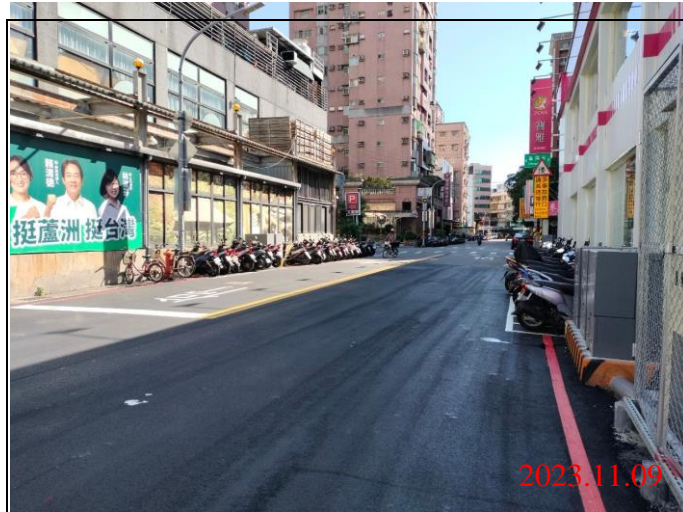
巡查日期地點：112.11.09/ Y21車站 照片說明：路面狀況
