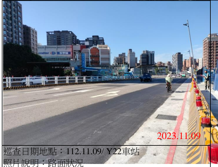
巡查日期地點：112.11.09/ Y22車站 照片說明：路面狀況
