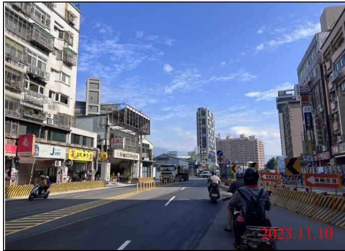
巡查日期地點：112.11.10/ Y22車站 照片說明：路面狀況
