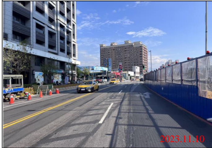
巡查日期地點：112.11.10/Y22車站 照片說明：路面狀況
