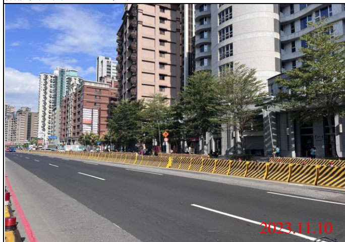
巡查日期地點：112.11.10/ Y23車站 照片說明：路面狀況
