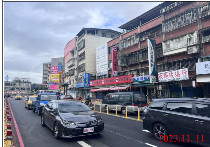
巡查日期地點：112.11.11/Y21車站 照片說明：路面狀況
