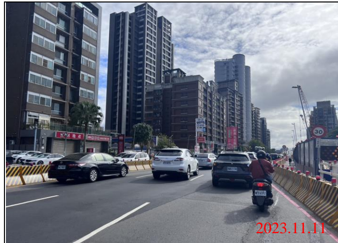
巡查日期地點：112.11.11/ Y23車站 照片說明：路面狀況
