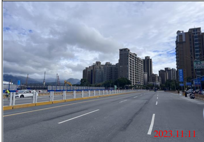
巡查日期地點：112.11.11/Y22車站 照片說明：路面狀況
