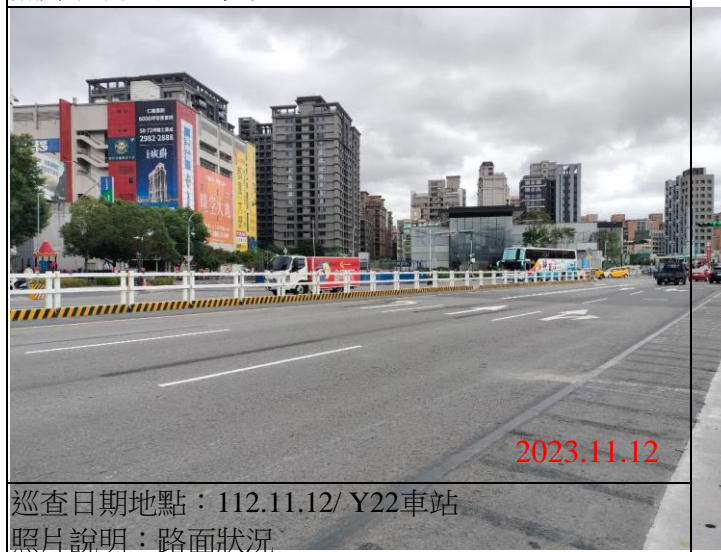
巡查日期地點：112.11.12/ Y22車站 照片說明：路面狀況
