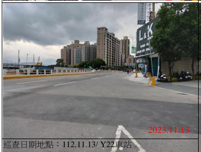
巡查日期地點：112.11.13/ Y22車站 照片說明：路面狀況
