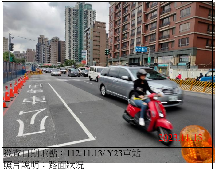
巡查日期地點：112.11.13/ Y23車站 照片說明：路面狀況
