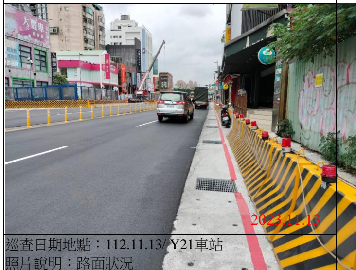
巡查日期地點：112.11.13/ Y21車站 照片說明：路面狀況
