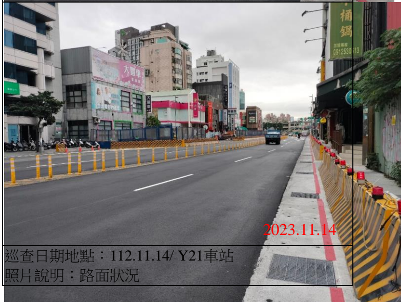
巡查日期地點：112.11.14/ Y21車站 照片說明：路面狀況
