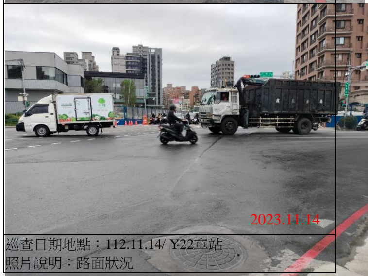
巡查日期地點：112.11.14/ Y22車站 照片說明：路面狀況
