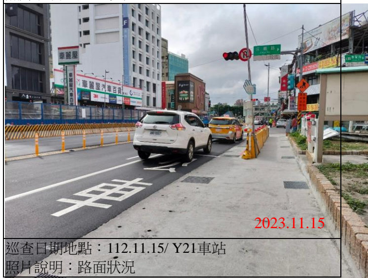
巡查日期地點：112.11.15/ Y21車站 照片說明：路面狀況
