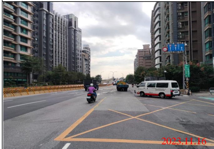
巡查日期地點：112.11.16/ Y23車站 照片說明：路面狀況
