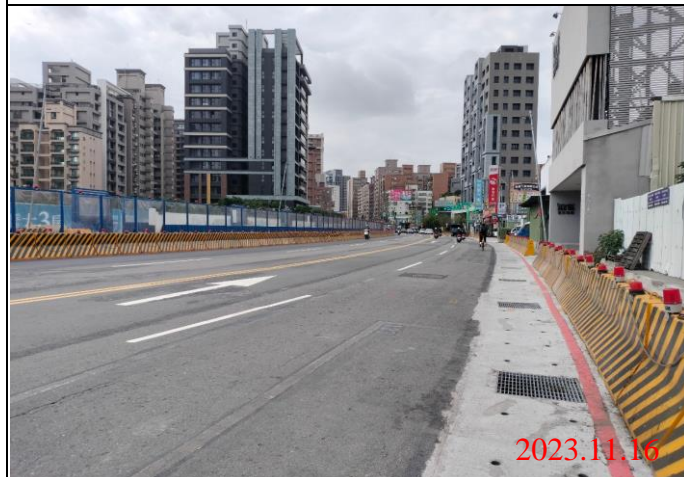
巡查日期地點：112.11.16/ Y22車站 照片說明：路面狀況
