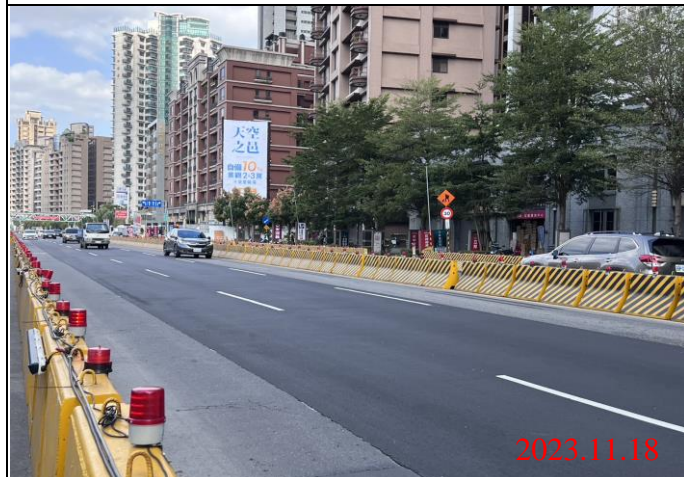
巡查日期地點：112.11.18/ Y23車站 照片說明：路面狀況
