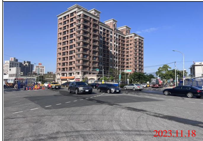
巡查日期地點：112.11.18/ Y22車站 照片說明：路面狀況
