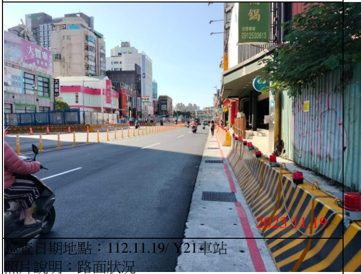
巡查日期地點：112.11.19/ Y21車站 照片說明：路面狀況
