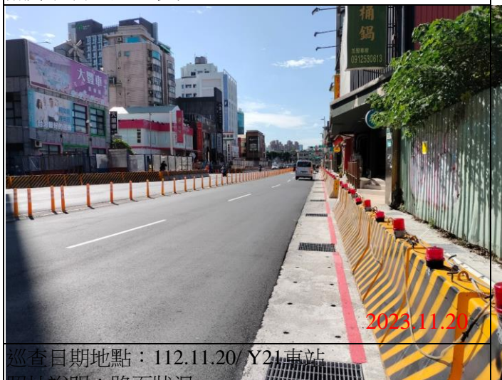
巡查日期地點：112.11.20/ Y21車站 照片說明：路面狀況
