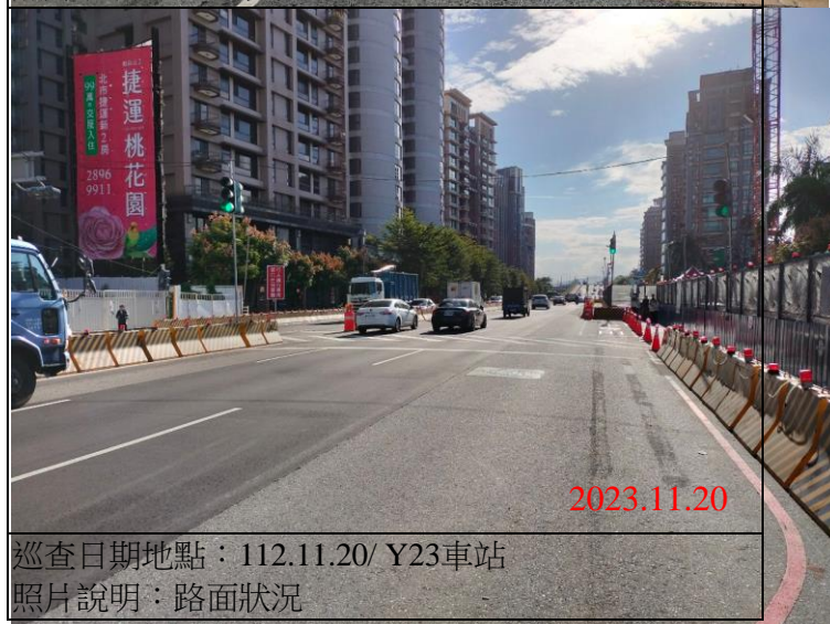
巡查日期地點：112.11.20/ Y23車站 照片說明：路面狀況
