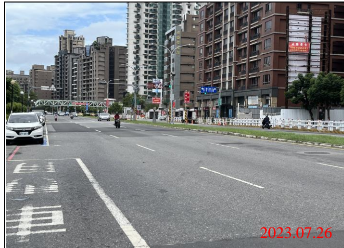
巡查日期地點：112.07.26/ Y23車站 照片說明：路面狀況
