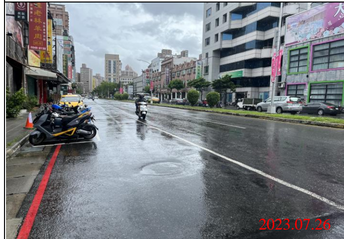
巡查日期地點：112.07.26/ Y21車站 照片說明：路面狀況
