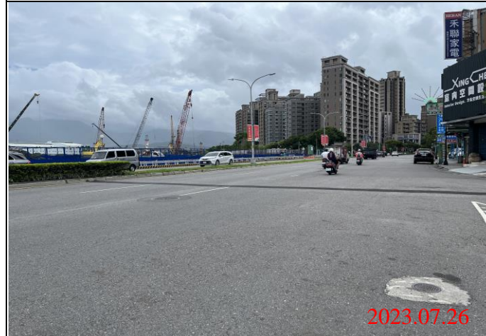
巡查日期地點：112.07.26/ Y22車站 照片說明：路面狀況
