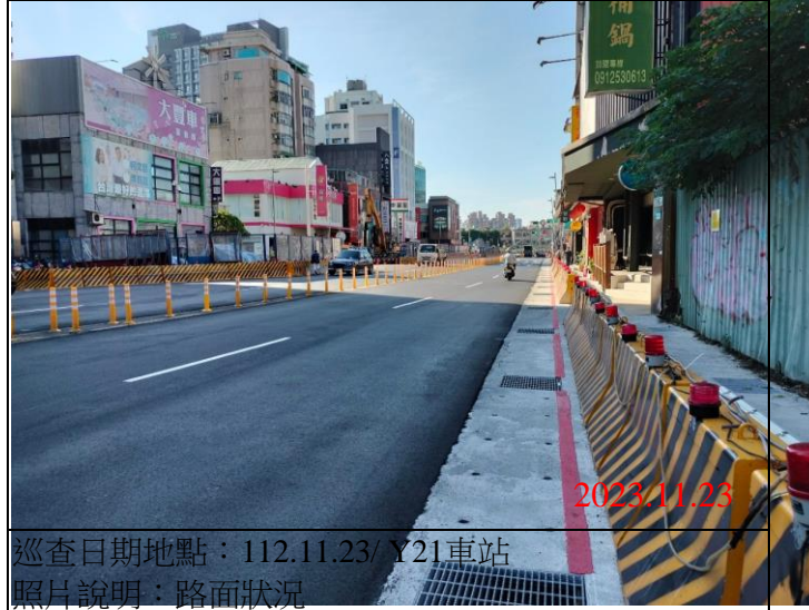
巡查日期地點：112.11.23/ Y21車站 照片說明：路面狀況
