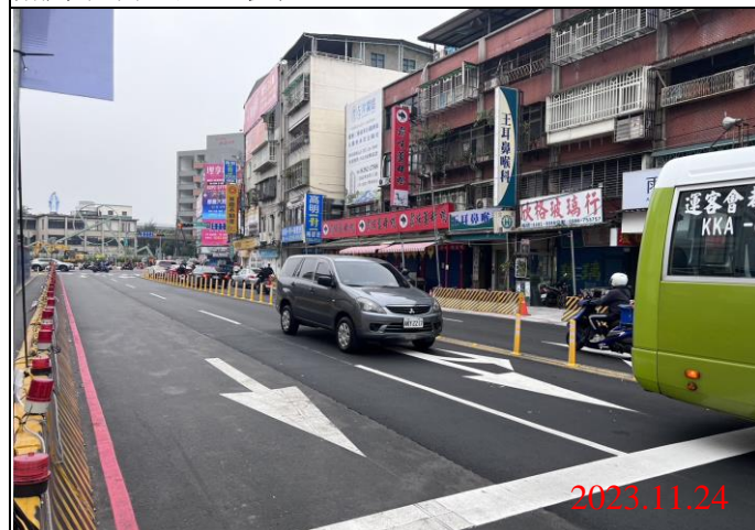
巡查日期地點：112.11.24/ Y21車站 照片說明：路面狀況
