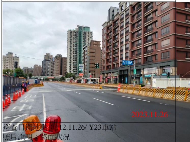
巡查日期地點：112.11.26/ Y23車站 照片說明：路面狀況
