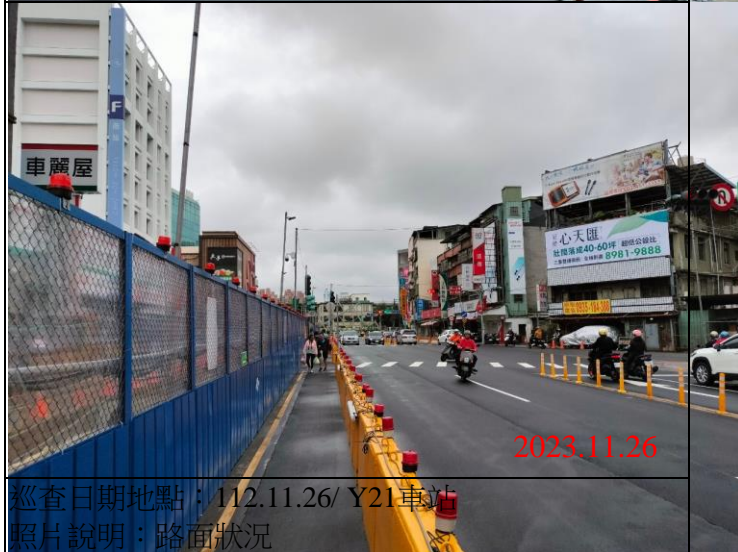
巡查日期地點：112.11.26/ Y21車站 照片說明：路面狀況
