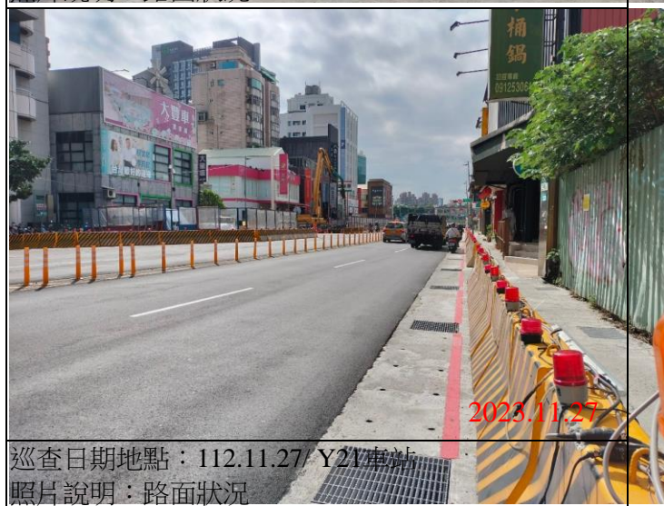
巡查日期地點：112.11.27/ Y21車站 照片說明：路面狀況
