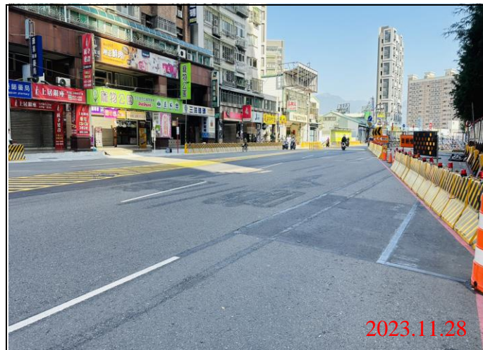
巡查日期地點：112.11.28/ Y22車站 照片說明：路面狀況
