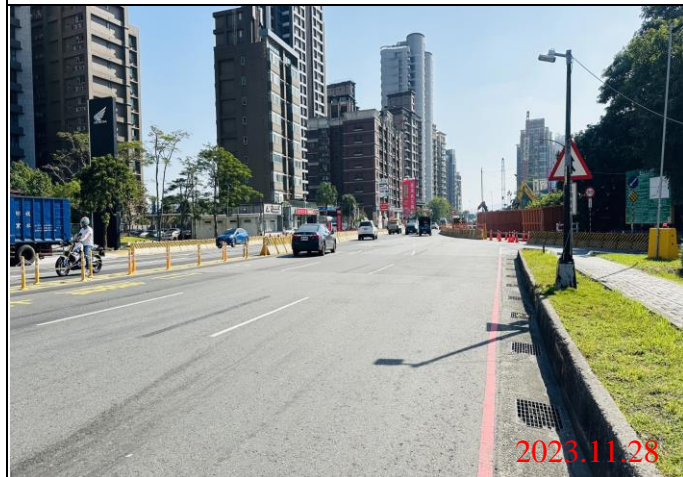
巡查日期地點：112.11.28/ Y23車站 照片說明：路面狀況
