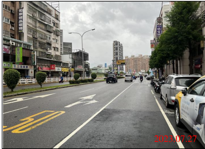
巡查日期地點：112.07.27/ Y22車站 照片說明：路面狀況
