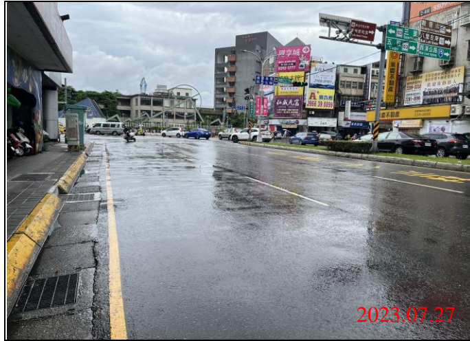
巡查日期地點：112.07.27/ Y21車站 照片說明：路面狀況
