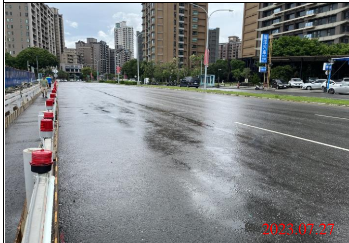
巡查日期地點：112.07.27/ Y22車站 照片說明：路面狀況
